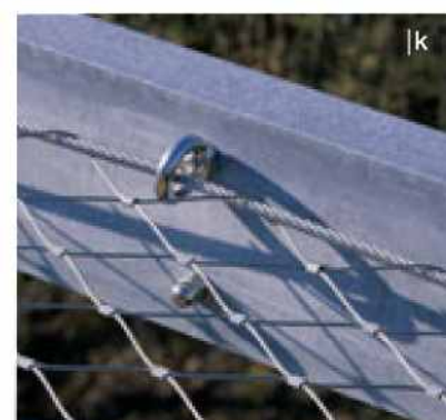
Cables periféricos y fijaciones
